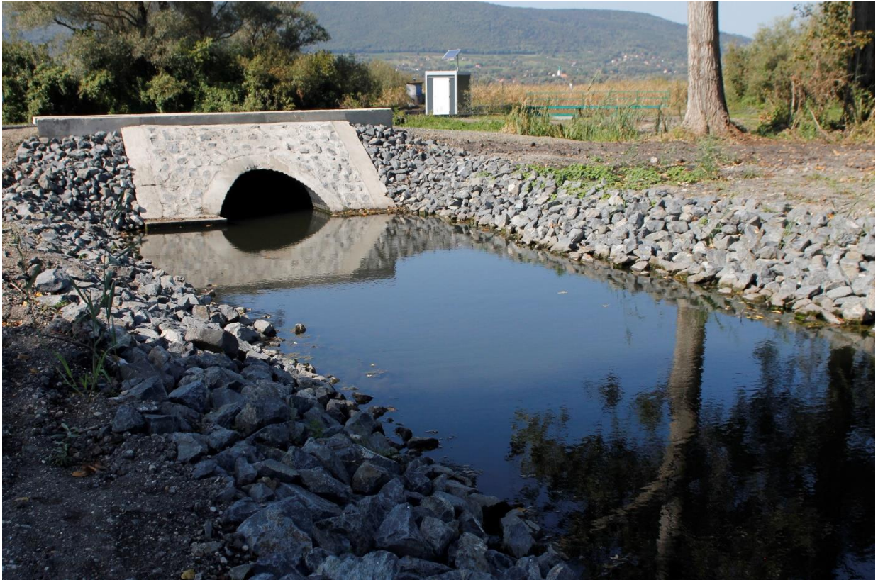
Lesence-patakon épített új átereszt
